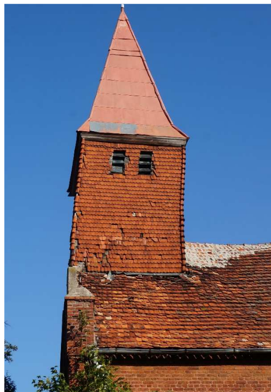
Fot. nr 4 Pochylenie wieży - zniszczone pokrycie wieży i dachu
