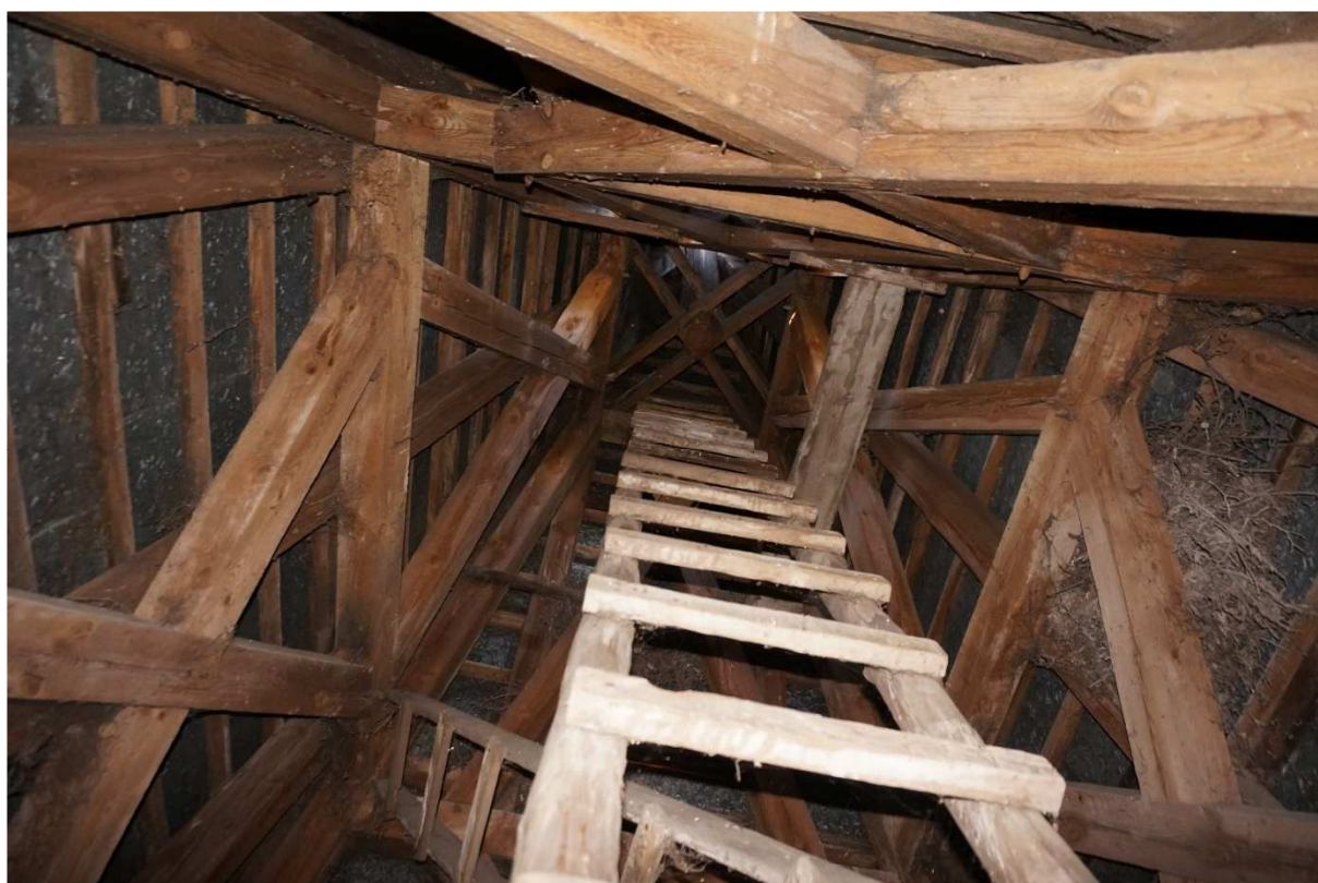
Fot. nr 15 Konstrukcja dachu wieży
