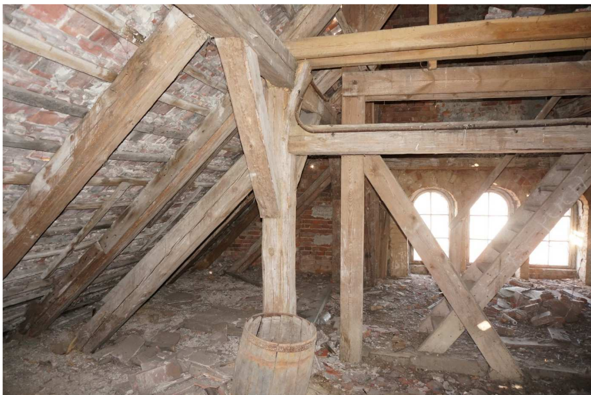
Fot. nr 9 Widok ogólny na konstrukcję drewnianą wieży na poziomie więźby dachowej kościoła – widać, że konstrukcja wieży jest niezależna.
