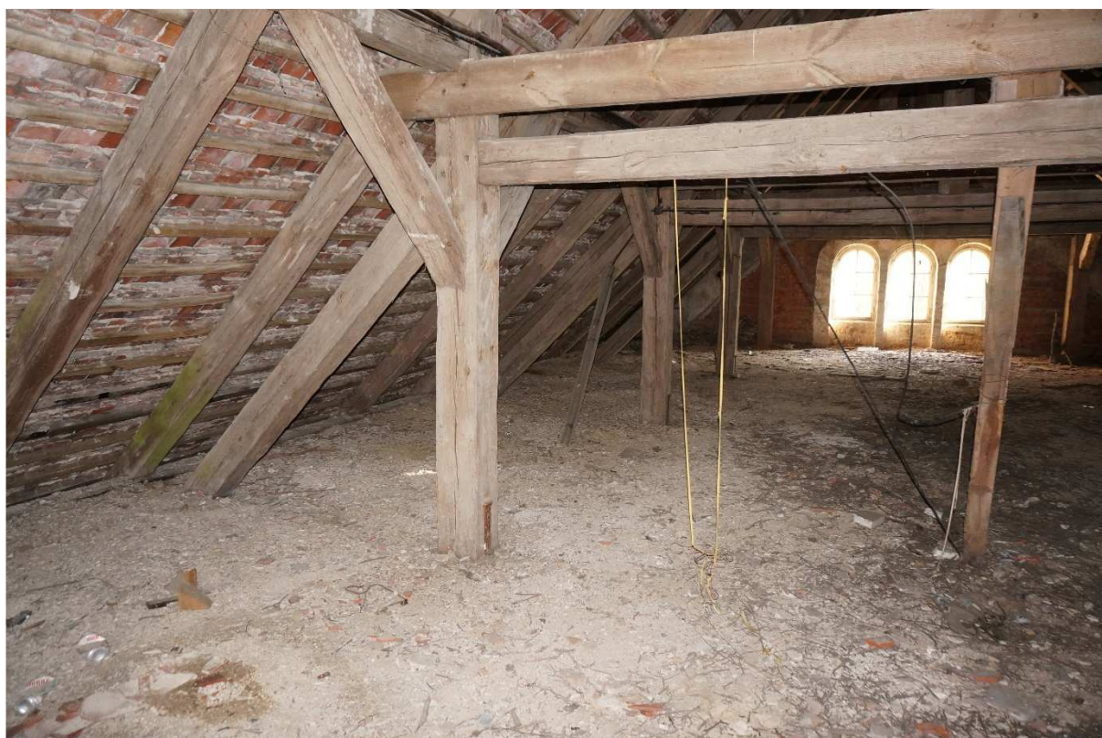
Fot. nr 7 Widok ogólny na konstrukcję wieżby dachowej – wydoczna krokiem z nalotem glonów (wpływ nieszczelnego dachu i przenikającej wilgoci)
