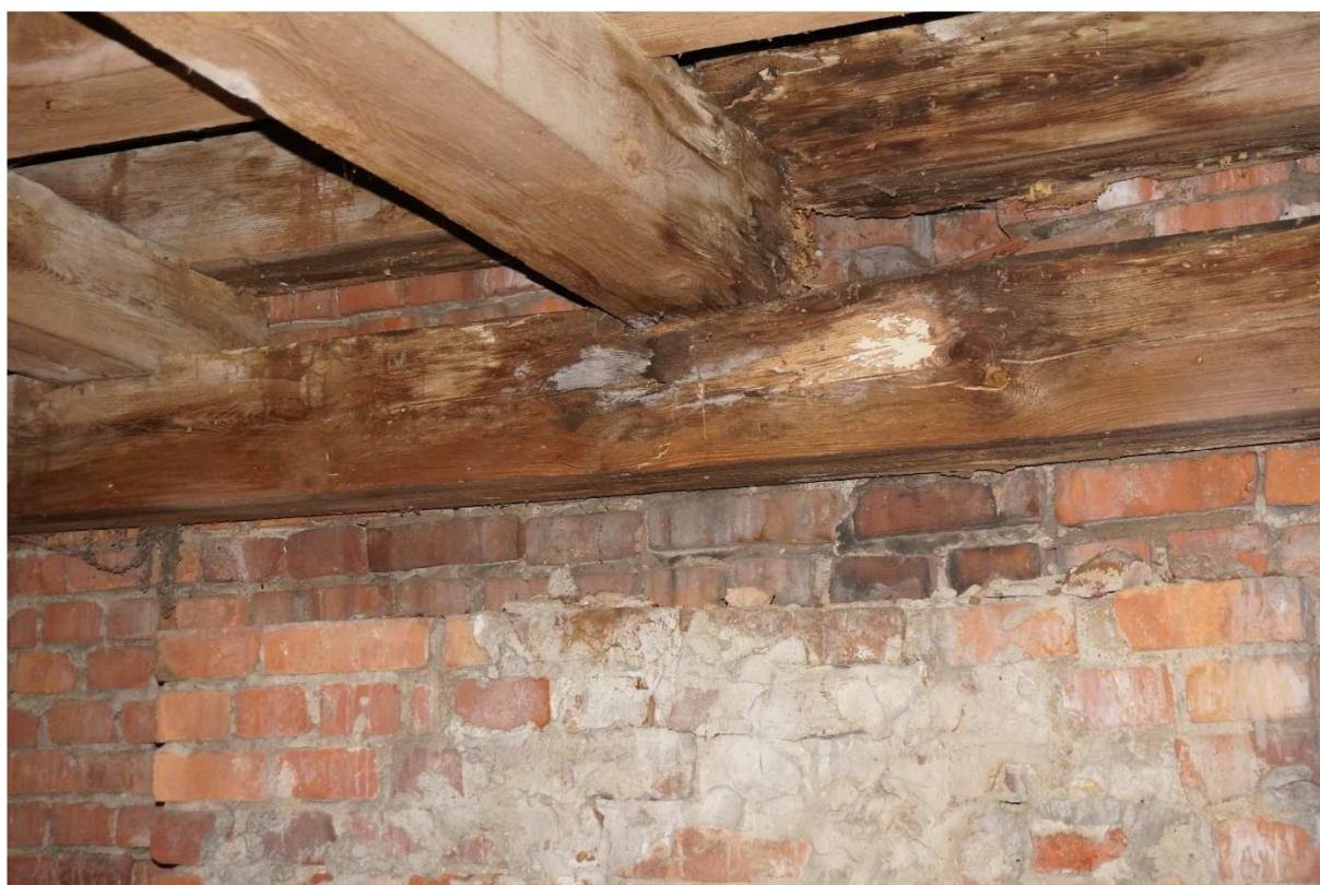
Fot. nr 11 Strop wieży – zniszczone belki przy ścianie szczytowej (skutek zalania)
