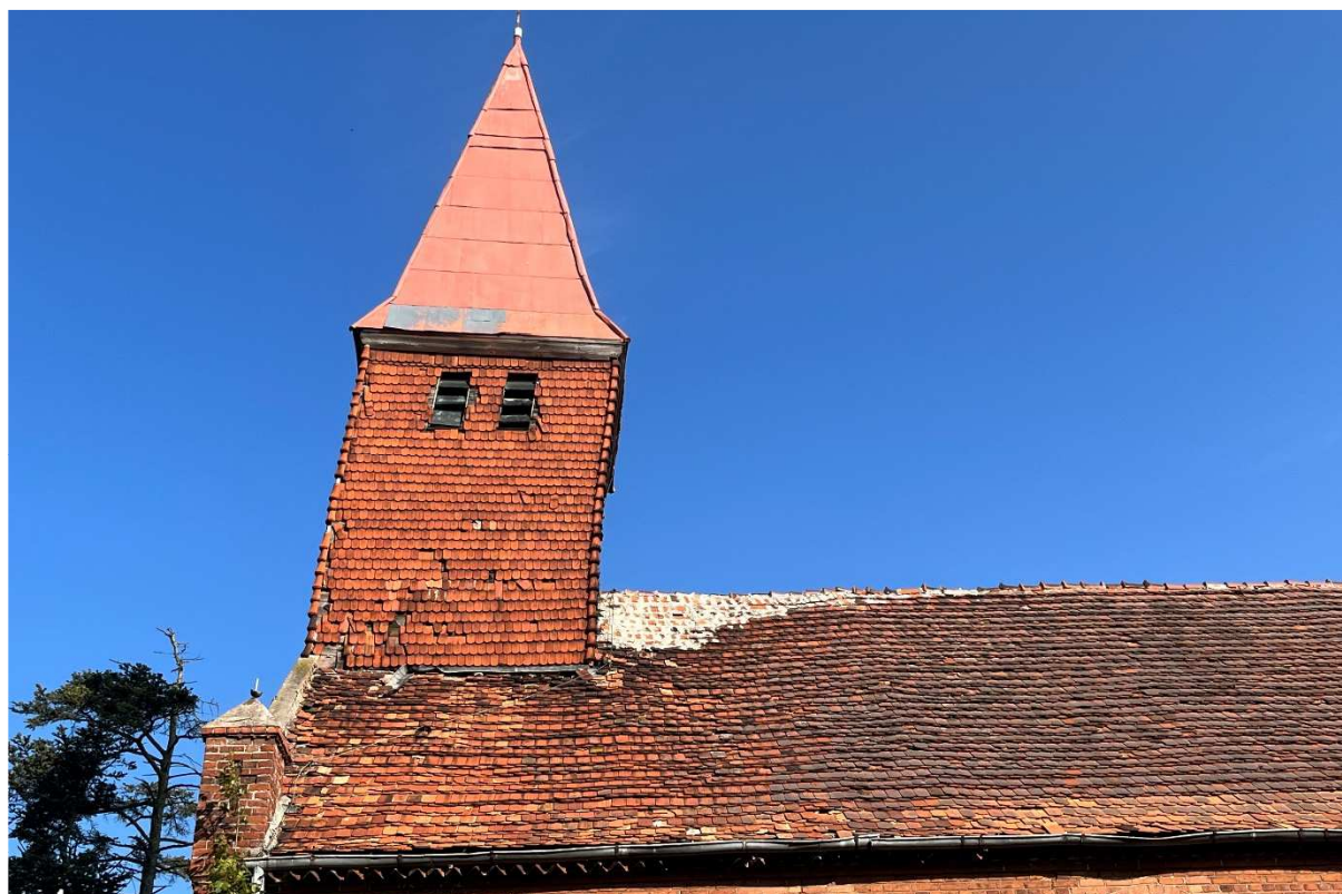
Fot. nr 2 Widok zniszczonego pokrycia dachu i wieży
